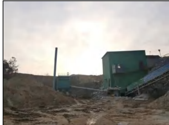
现有工程颚式破碎机及除尘器图
