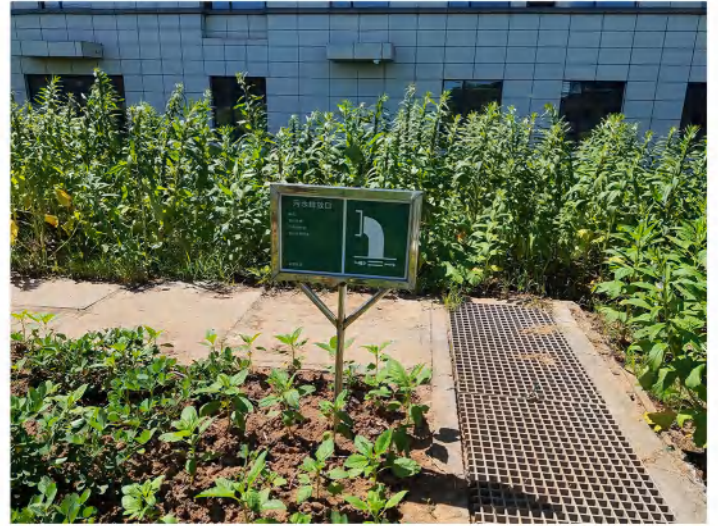
现有工程污水排放口
