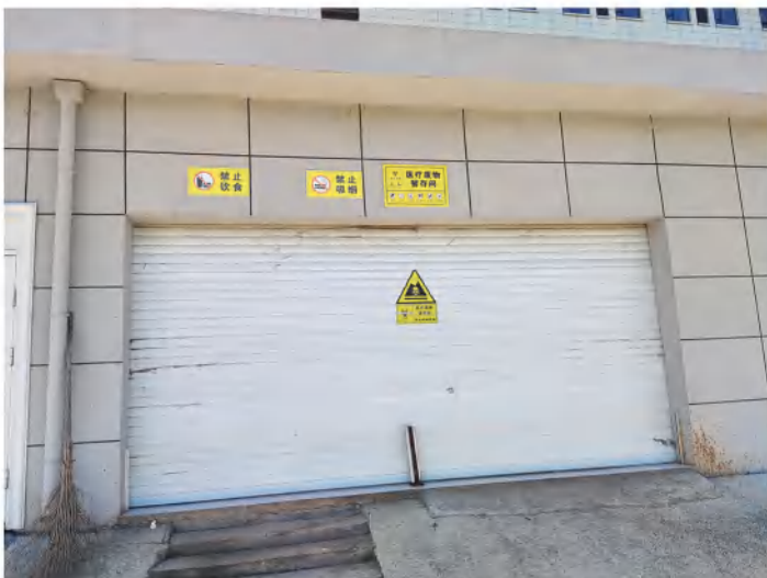
现有工程医疗废物暂存间
