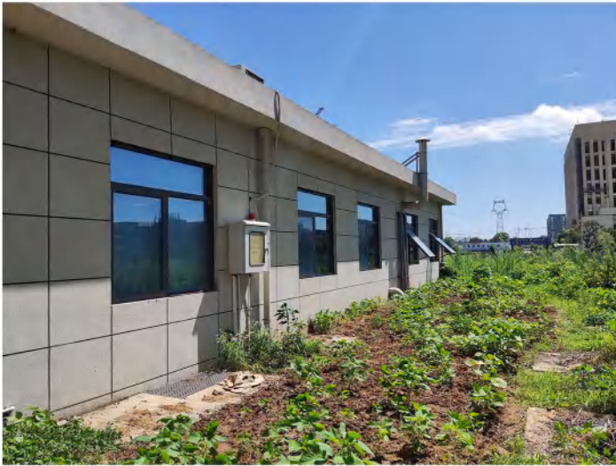
现有工程污水处理站
