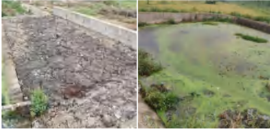
图 2-12 现有污水处理设施现场照片
