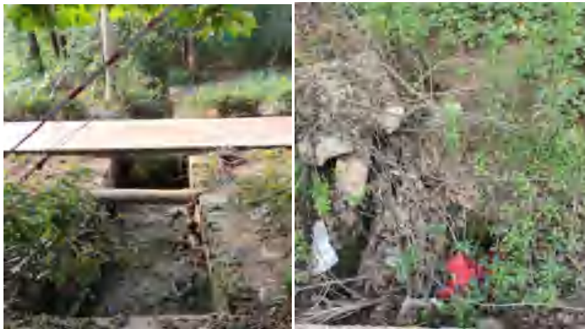
图 2-14 部分沟渠的现场照片
