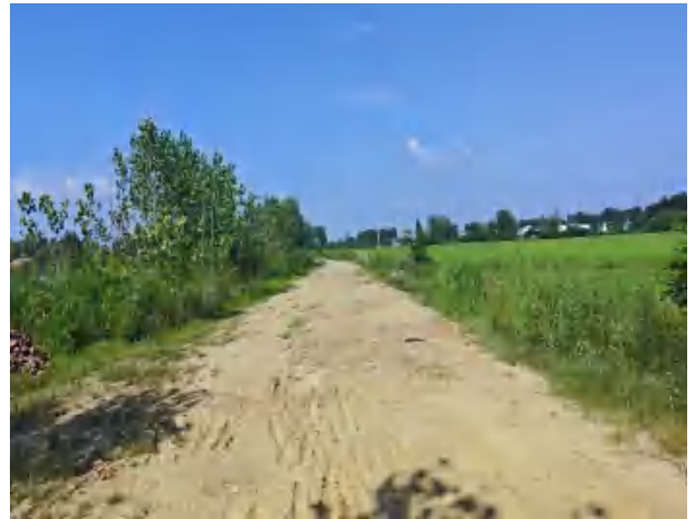
JH06 风机改建道路现状
